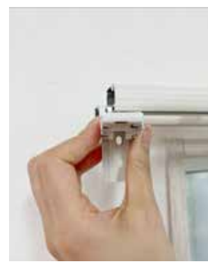
レール用取付金具と、取 り付けたブラケットをすべ てレールの溝に入れます。
