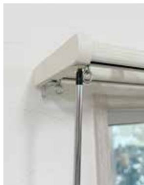
レールのエンドキャップを 外しランナーを抜きます。
